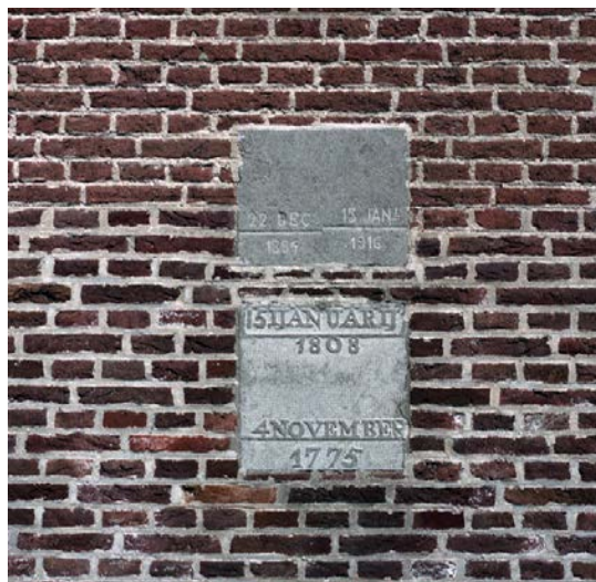
Pijlmerstenen in dijkwoning te Willemstad: ter herinnering aan diverse watersnoodrampen © https://beeldbank.rws.nl , Rijkswaterstaat / Rens Jacobs
